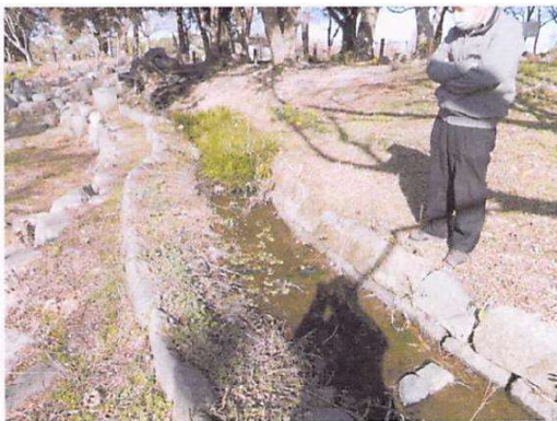
ビオトープ池・ホタル水路脇の清掃作業 （1月7日）
